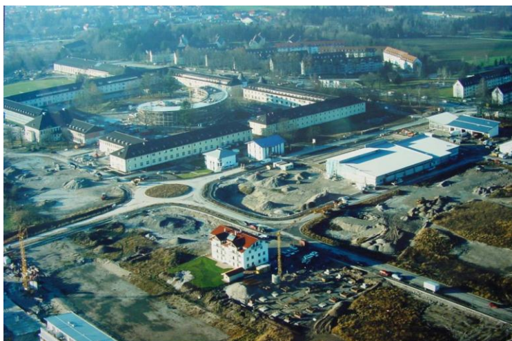
Kaserne während der Bodensanierung
