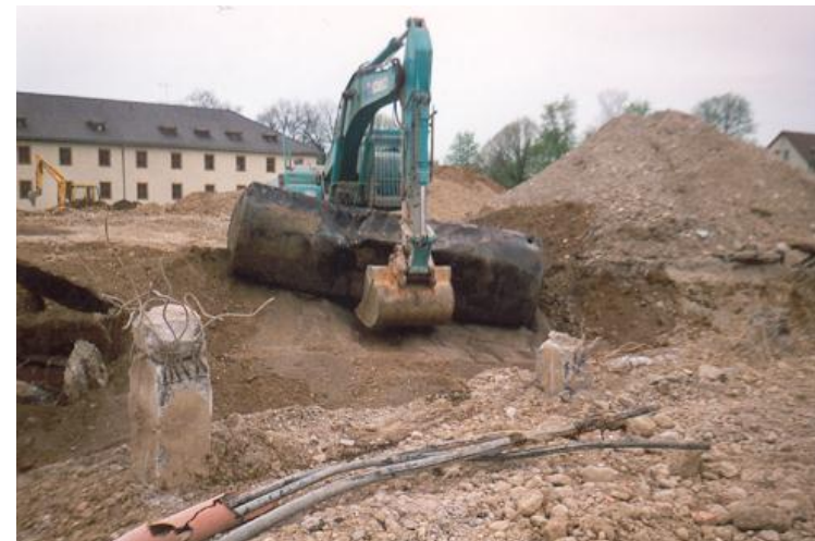
Bergung eines Erdtanks
