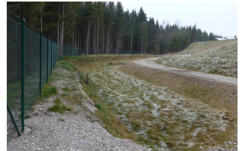
Blick auf die neu angelegte Sickermulde am Böschungsfuß
