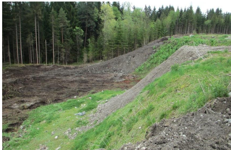
Böschungsbereich der Deponie vor der Sanierung
