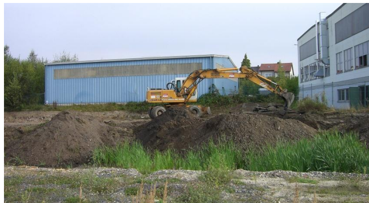
Bodenaushub zur Entfernung lokaler Verunreinigungen
