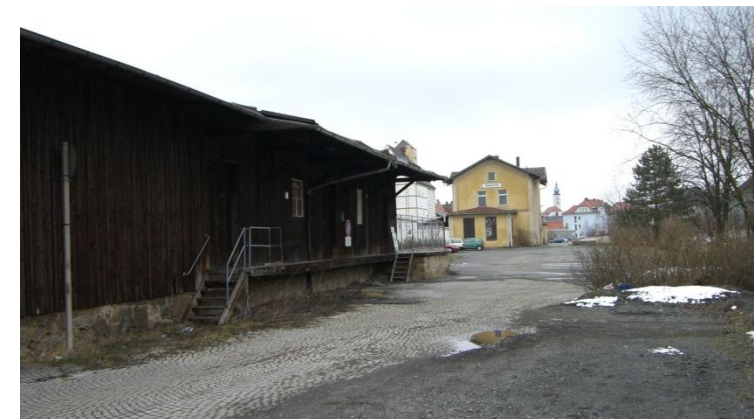
Ehemaliges Bahnhofsgelände vor der Sanierung
