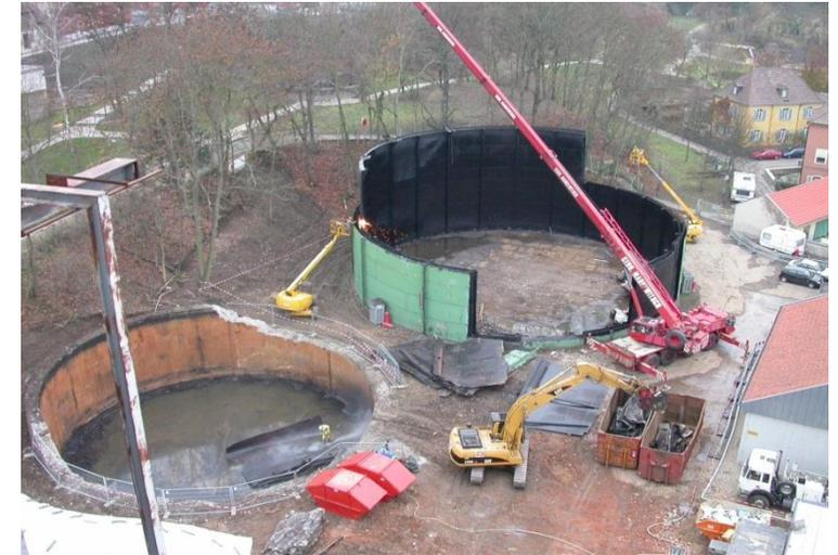
Rückbau der Gasbehälter mit Abtrennung der Behälterwandungen
