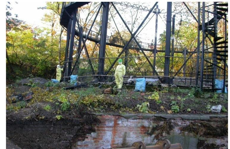
Rückbauarbeiten an einem Gasbehälter des ehemaligen Gaswerks
