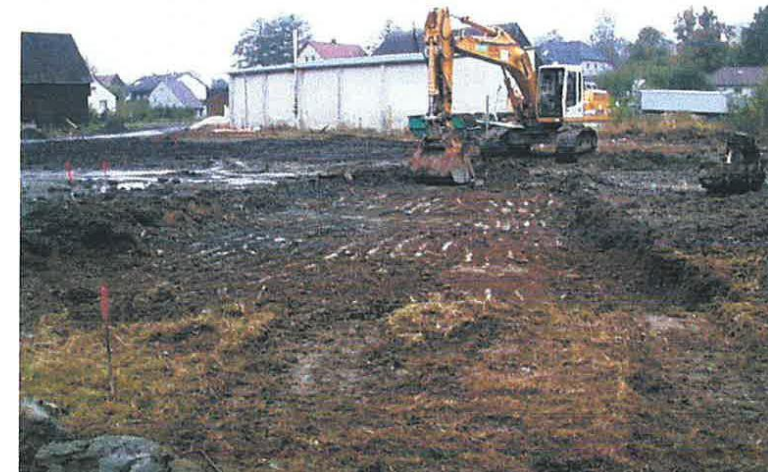
Aushub der Auffüllung
