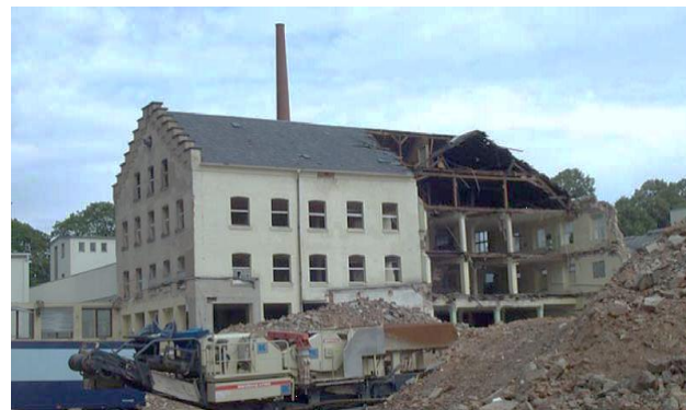
Abbruch von Gebäuden und Brennöfen mit mobiler Bauschuttbereitung
