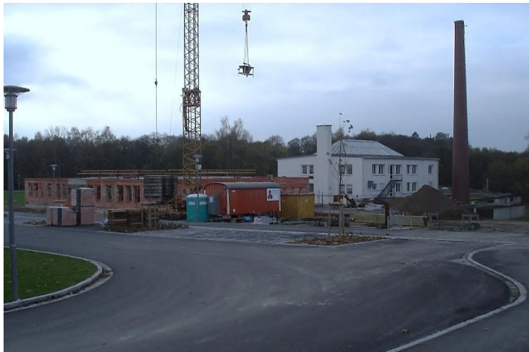
Neubau auf dem Gelände der ehemaligen Porzellanfabrik
