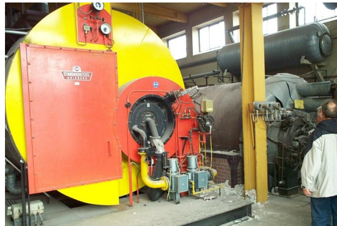
Blick in die Generatorenhalle
