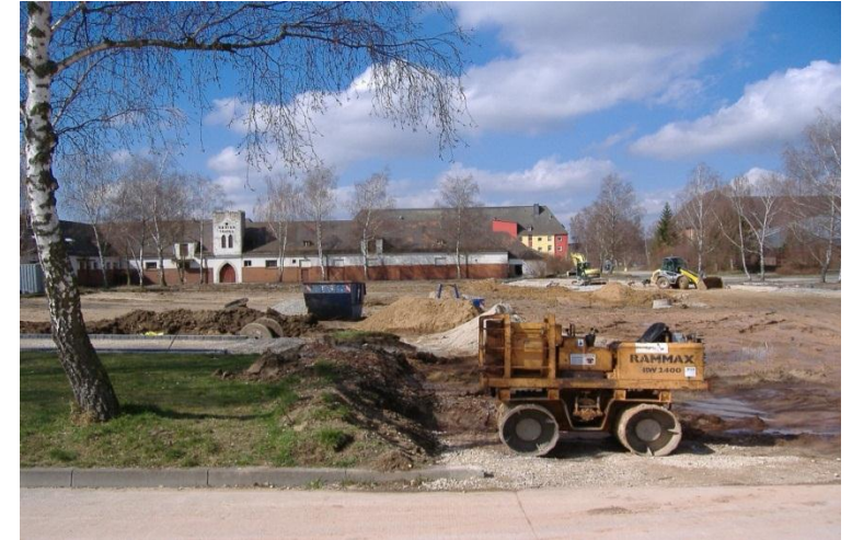
Baumaßnahmen am Quartiersplatz
