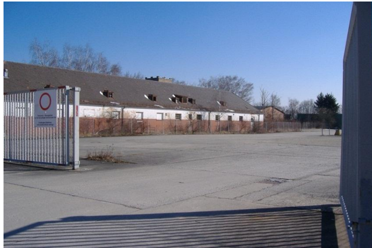
Kaserne nach Stilllegung, vor der Sanierung
