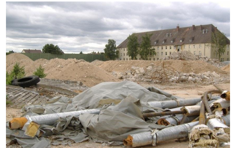
Abbrucharbeiten für das neue Wohngebiet
