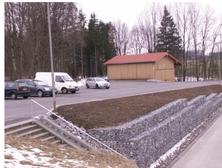
Neu errichtete Salzhalle und neuer Parkplatz für den Sportplatz
