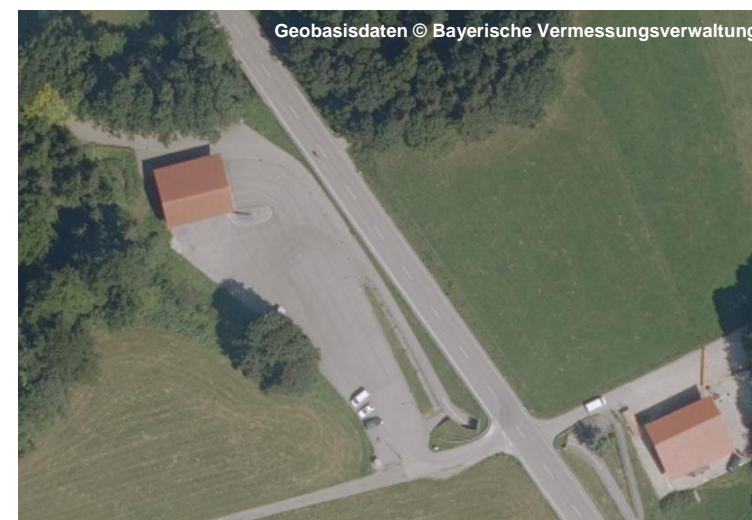
Neue Deponieabdeckung mit Salzhalle (links oben), Aufnahme 2015
