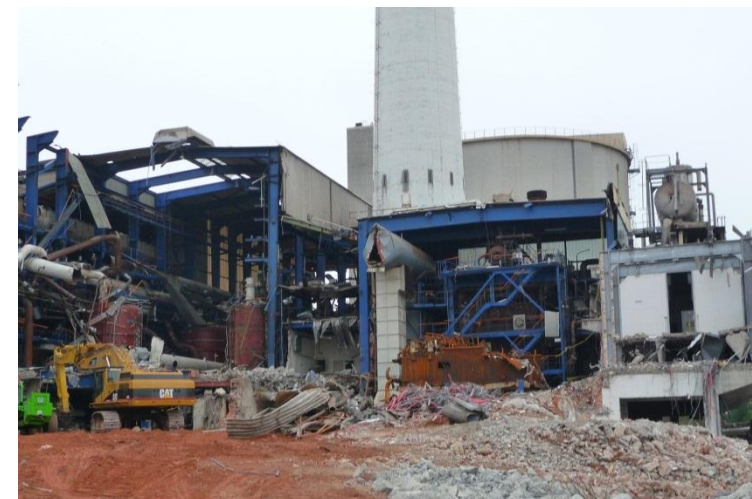
Selektiver Rückbau der Gebäude zur Zuckerfabrikation, 2009
