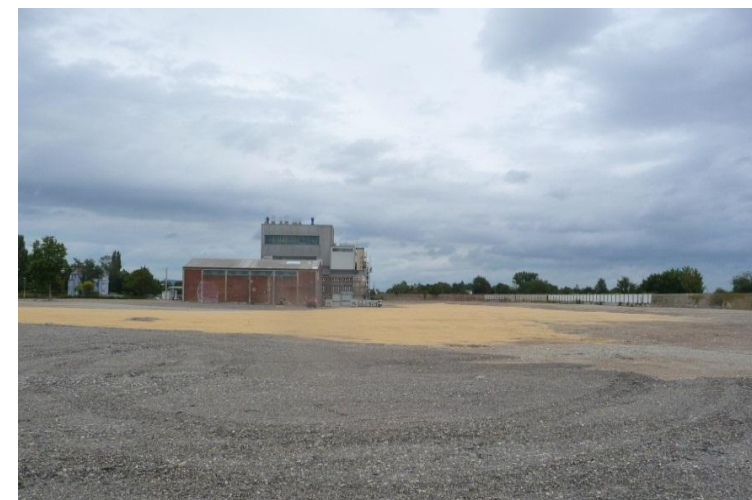
Das Gelände nach der Fertigstellung des Rückbaus, 2011
