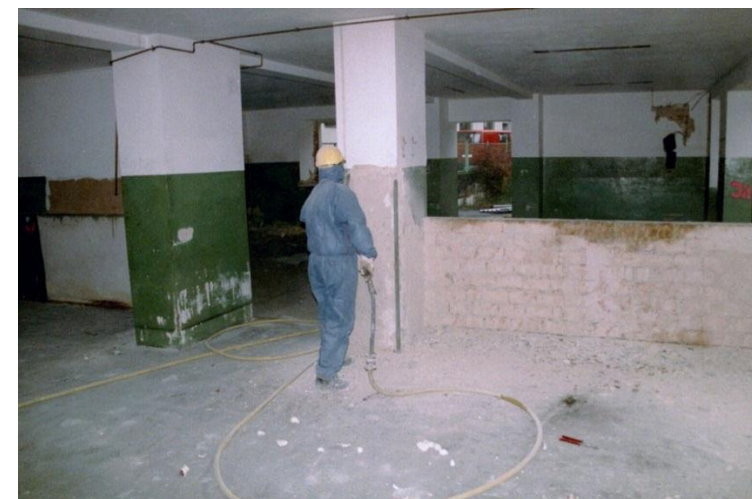
Entfernung von Wandanstrichen vor dem Rückbau
