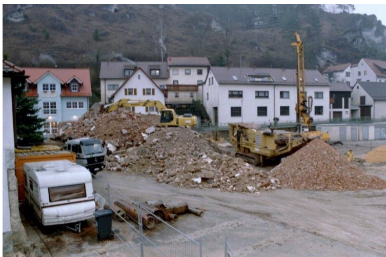
Recycling der mineralischen Bausubstanz durch eine mobile Bauschuttbreitungsanlage (auf dem Sanierungsgelände)
