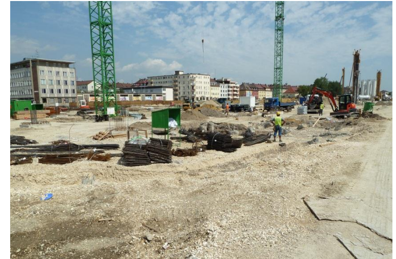
Baustelleneinrichtung auf der ehemaligen Güterbahnhofsfläche
