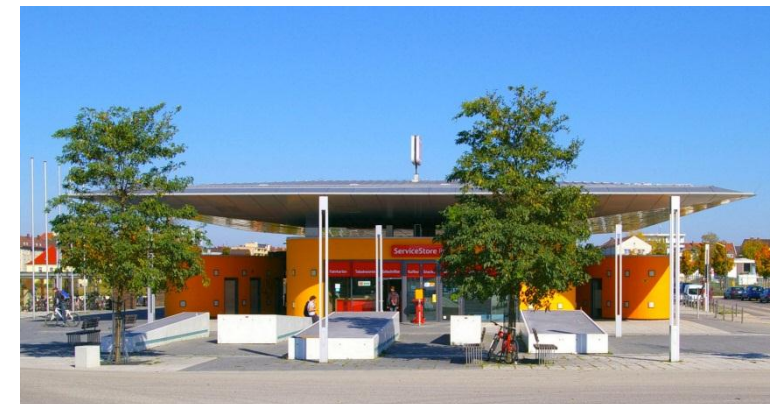
Das 2007 neu errichtete Bahnhofsempfangsgebäude
