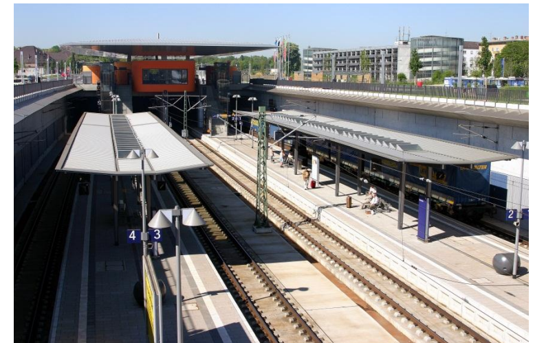
Bahnsteiganlage im neuen Bahnsteigtrog
