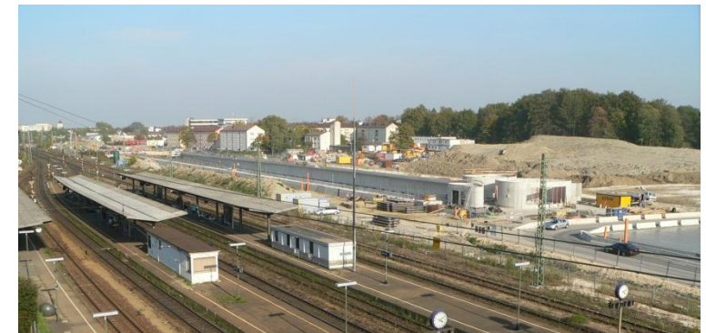
Alte Bahnhofsanlage (links) und Baustelle für den neuen Bahnhof (rechts)
