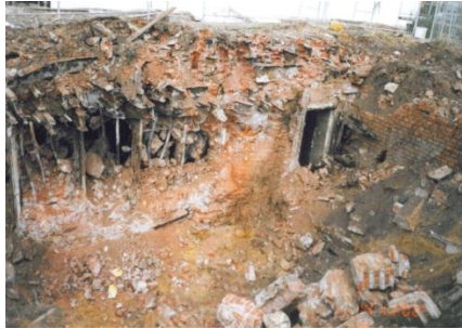
Abriss alter Kellerräume
