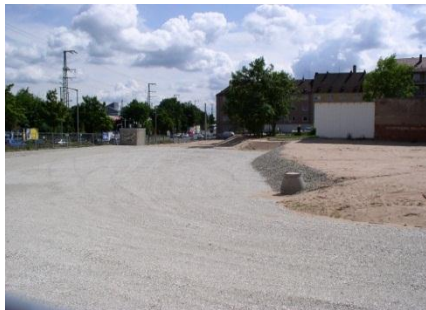
Verfüllte Baugrube vor dem Neubau
