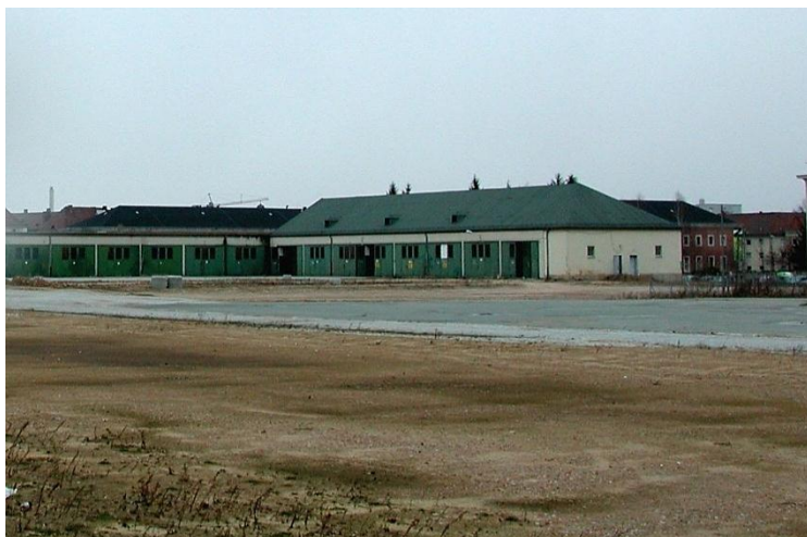
Ehemaliger Gebäudebestand der Kaserne
