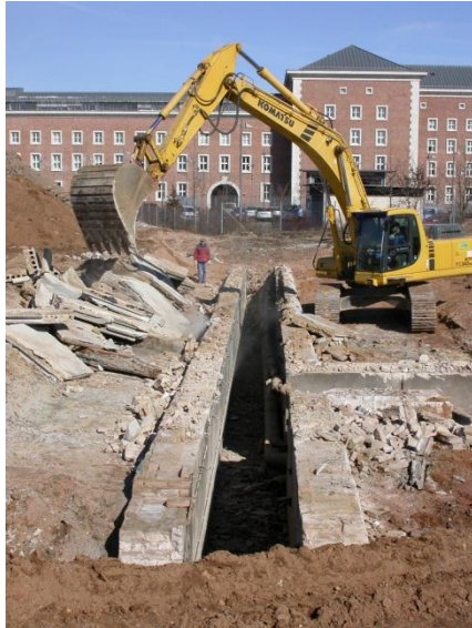
Rückbau eines Tunnels
