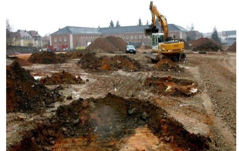
Aushub der Auffüllungen
