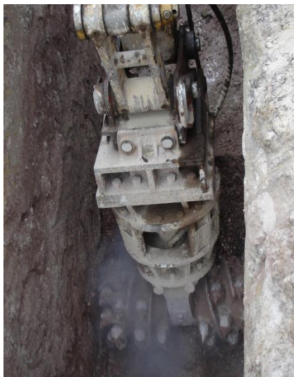
Fräsen des Drainagegrabens
