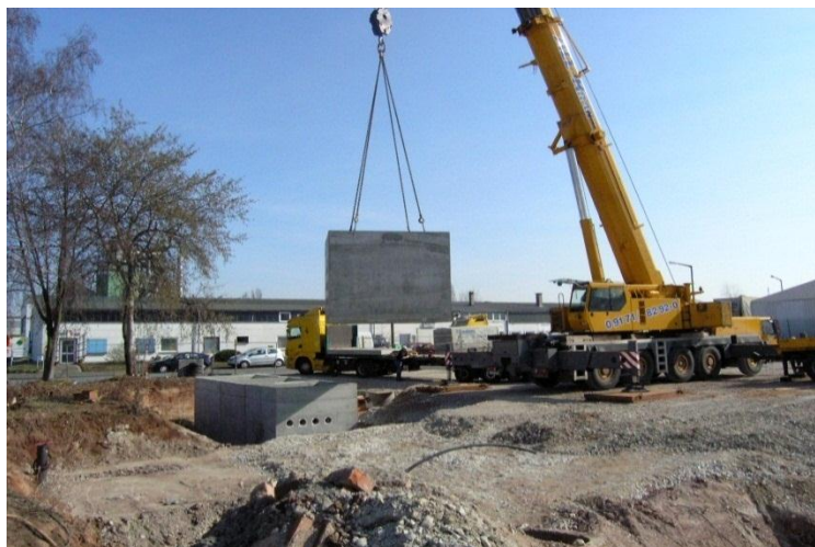
Einbau des zentralen Sanierungsschachtes
