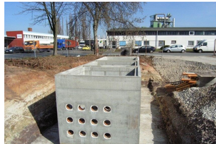
Eingebauter Sanierungsschacht mit Anschlussstellen für Rohrleitungen
