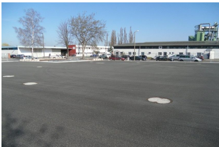
Neue Asphaltdecke nach Abschluss der Bodensanierung
