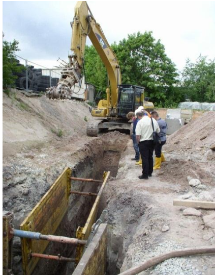
Mit Grabenverbau gesicherter Fräsgraben
