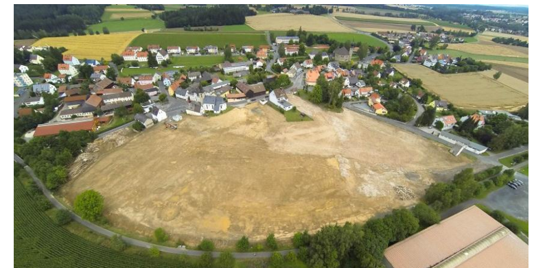
Die Fläche nach der Sanierung im Juli 2014
