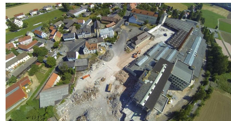
Abbrucharbeiten im August 2013
