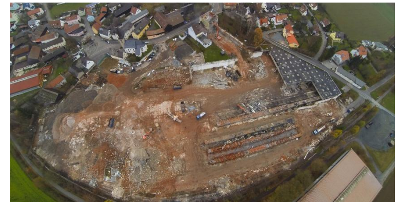
Fortschritt der Abbrucharbeiten im November 2013
