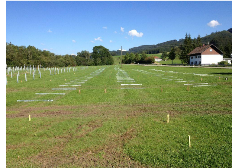
Beginn des Anlagenbaus im September 2013
