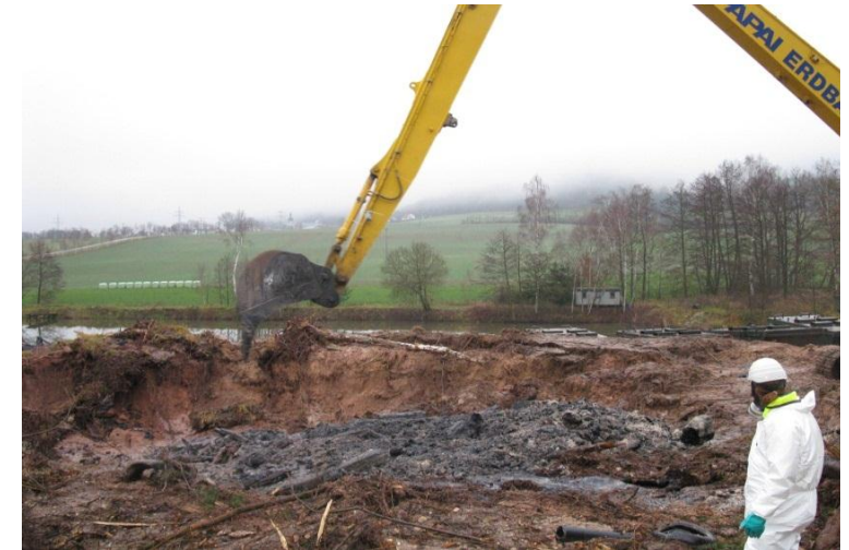
Aushub der Säureharz-Boden-Gemische unter Arbeitsschutz
