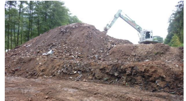
Deponiekörper mit sanierter Basis im Vordergrund
