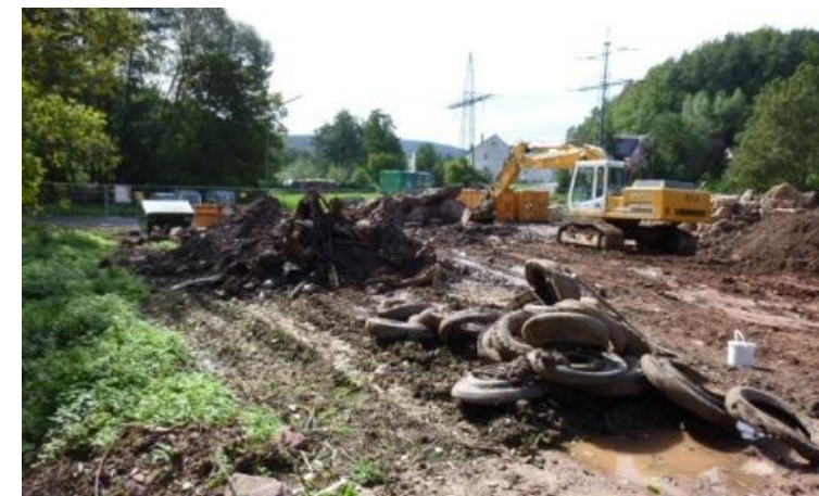
Grobe Müllsortierung im Zuge des Aushubs
