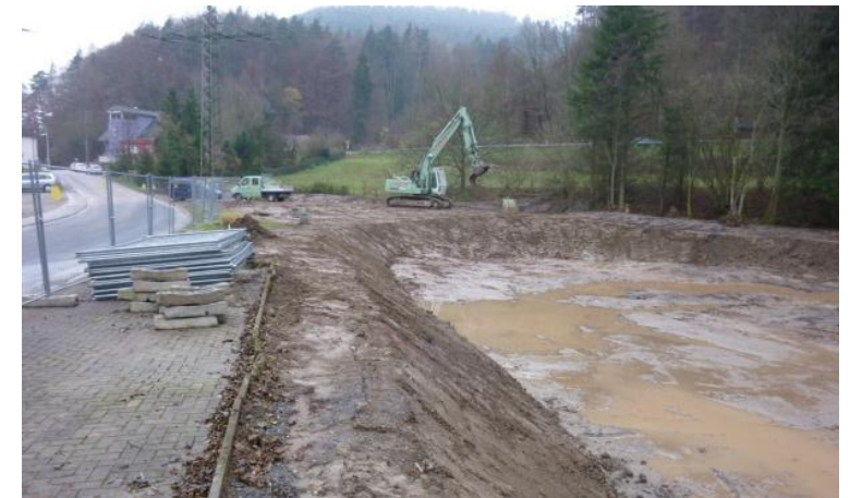
Nach Abschluss der Aushubmaßnahme
