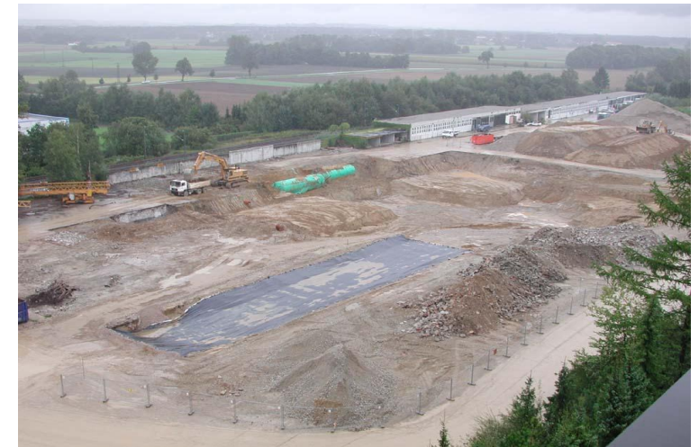
Übersichtsaufnahme während der Bodensanierung
