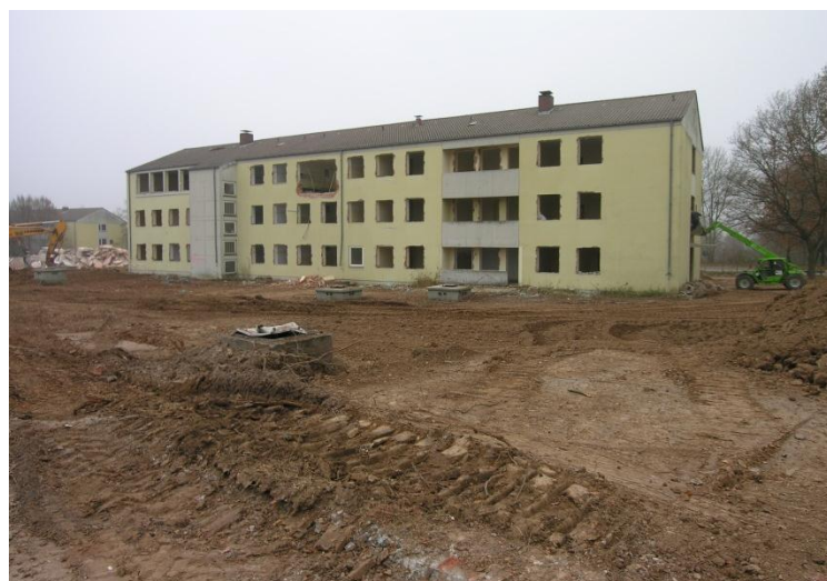
Dekontaminiertes und entkerntes Kompaniegebäude
