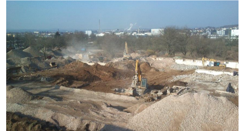
Gebäuderückbau, Geländeprofilierung und Recyclingmaterial
