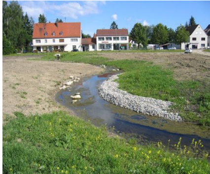
Sanierter Bachlauf des Steglesgrabens
