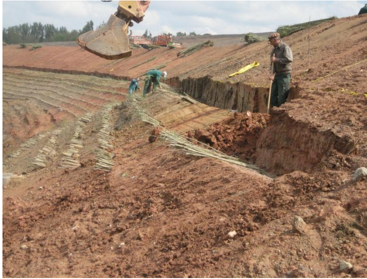
Die Weidenruten zur Böschungssicherung werden in Handarbeit eingesetzt
