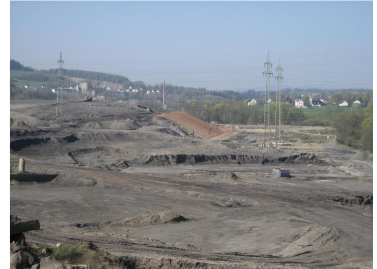
April 2009: Das Kraftwerk ist komplett rückgebaut und die Umlagerung der Aschenhalde mit Oberflächenabdeckung beginnt
