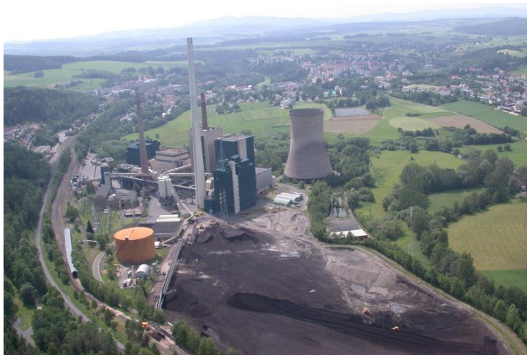
Ehemaliges Kraftwerk Arzberg zu Beginn der Rückbauphase im Jahr 2003. Im Vordergrund ist der Kohle- und Aschenlagerplatz zu erkennen.
