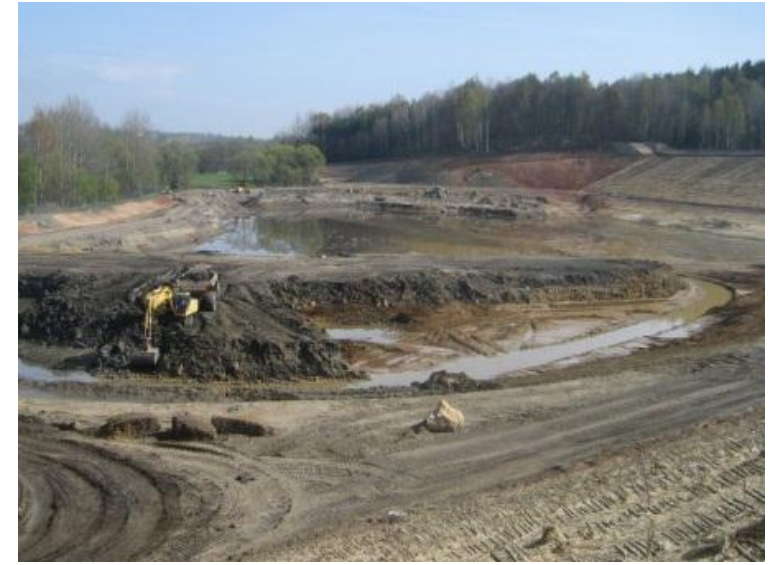
Umlagerung der Flug- und Rostaschen aus dem Lagerplatz im April 2010
