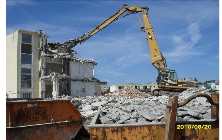
Abbrucharbeiten an einem ehemaligen Wohngebäude
