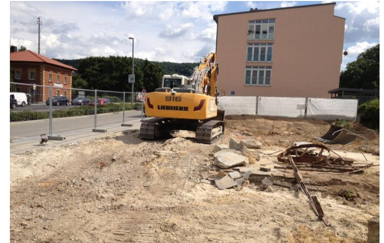
Beginn der Bodensanierung nach Gebäudeabbruch
