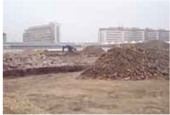
Flächenrecycling auf einem ehemaligen Gaswerksstandort
