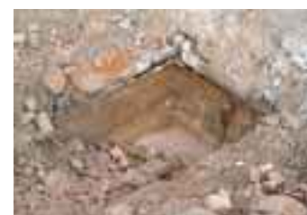
Abbruch eines Raumes Leere Neutralisierungsgrube
