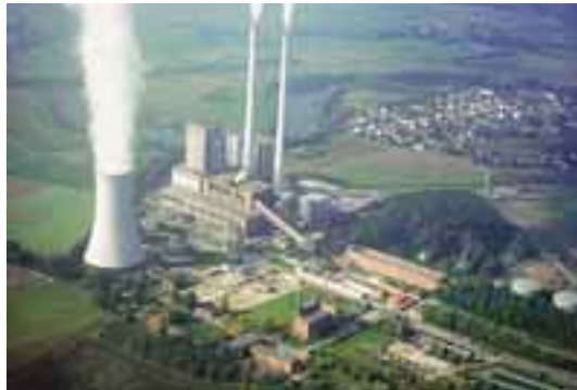
Luftbild des ehemaligen Braunkohlekraftwerks Dachelhofen
