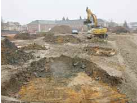
Bodensanierung auf einem Altstandort
