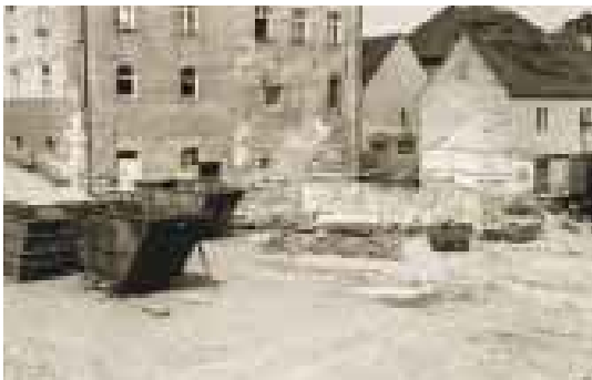
Baustellensituation 1981, 6 Tage nach Schadensentdeckung
