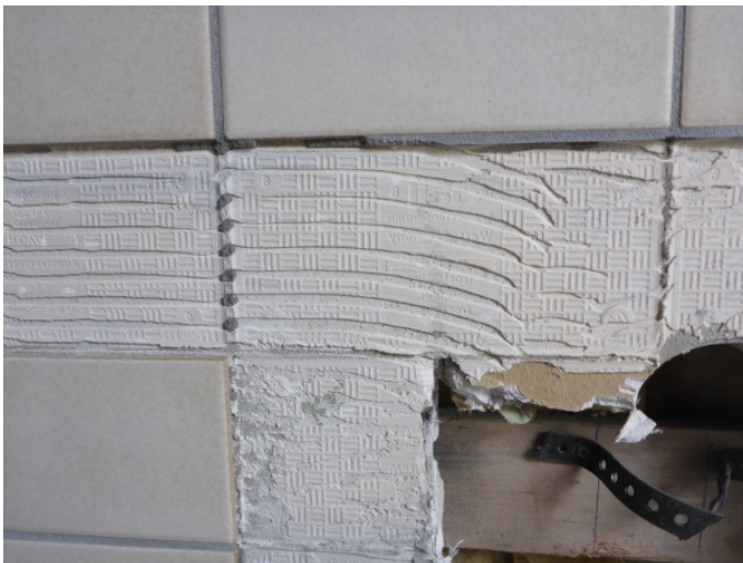
Abb. 1: Asbesthaltiger Dünnbettmörtel
