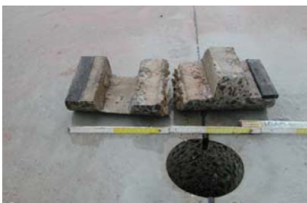
Abb. 1: Fugenverguss zwischen Betonplatten
