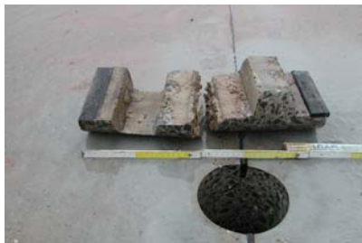
Fugenverguss zwischen Betonplatten
