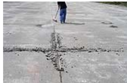
Teerfugen zwischen Beton- platten
