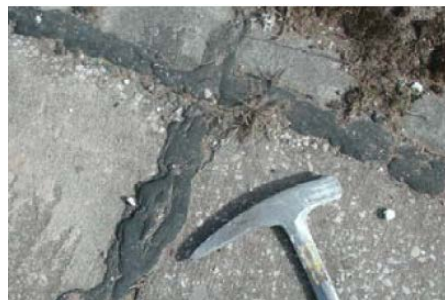
Abb. 2: Teervergussmasse zwischen Betonbodenplatten
