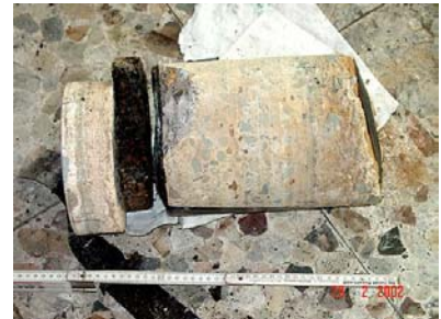
Teerkorkdämmschicht unter Bodenbelag und Estrich
