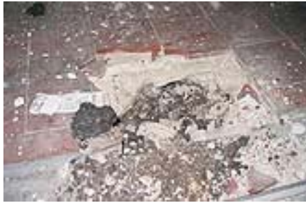
Teerkorkisolierung unter Estrich und Fliese
