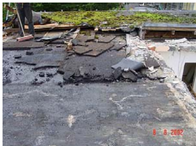
Dämmschicht aus Teerkork im Dachbereich
