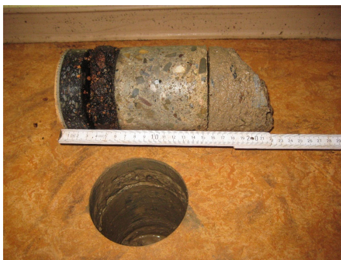
Abb. 4: Gussasphalt auf Teerkorkdämmung
