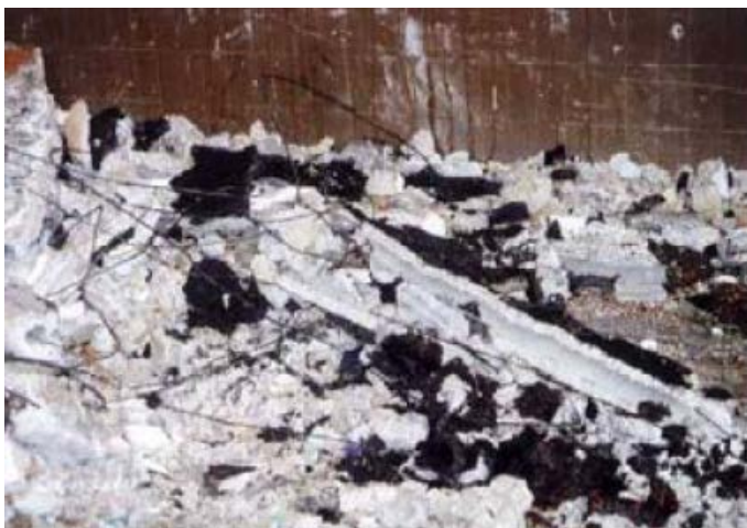
Abb. 1: Zerbrochene Teerkorkisolierung im Bauschutt
