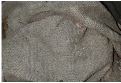
Asbestmatte, hier eingesetzt als Brandschutzverkleidung
