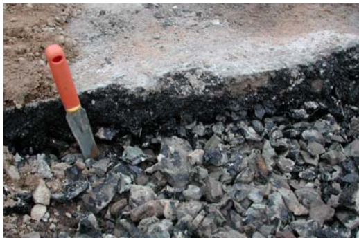
Schwarzdecke auf Unterbau
