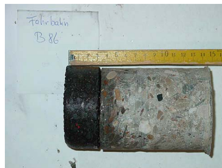
Kernbohrung, Betonboden mit PAK-haltiger Schwarzdecke
