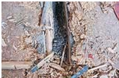
Fehlbodenschüttung aus Ofenschlacke schwarz
