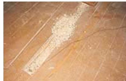
Fehlbodenschüttung (beige) unter Holzboden
