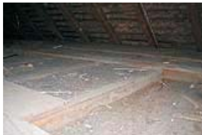
Fehlbodenschüttung im im Dachboden
