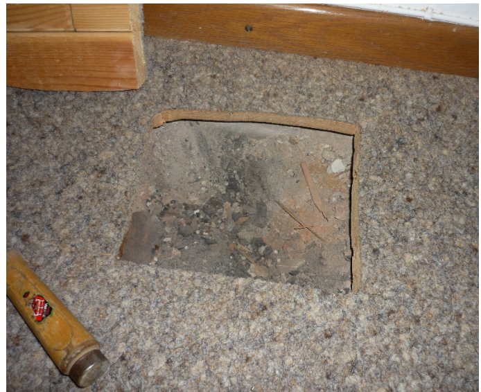
Abb. 2: Fehlbodenschüttung aus Schlacke
