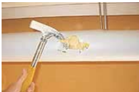
KMF-haltige Rohrisolie- rung (gelb)
