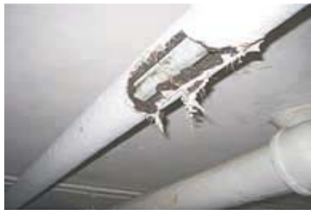
Rohrisolierung aus Teerkork (schwarz) mit Gipsmantel
