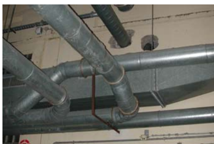
Rohrverkleidungen aus Leichtmetallschalen
