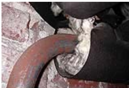
Rohrisolierung aus KMF (weiß) mit Teerpapierummantelung (schwarz)
