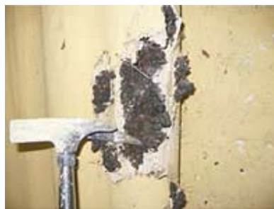
Rohrisolierung aus Teerkork (schwarz) mit Gipsmantel (beige)
