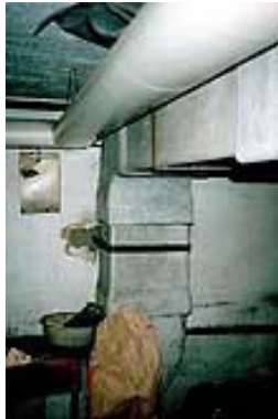
Lüftungskanal aus Asbestzement
