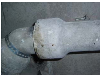
Abwasserrohr aus Asbestzement
