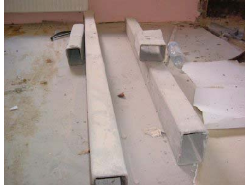
Lüftungskanal aus Asbestzement
