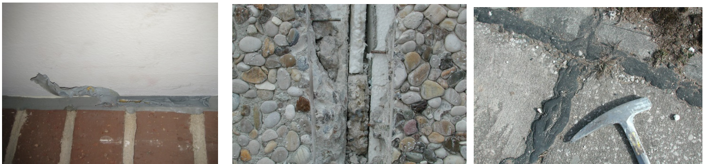
Abb. 1: Fugen mit Dichtmasse
