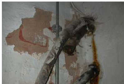
Stromkabel, umwickelt mit teerölgetränktem Gewebe
