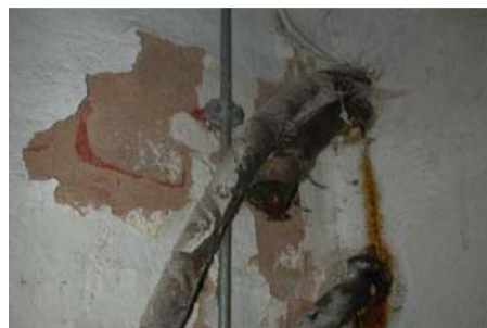
Abb. 2: Stromkabel, umwickelt mit teerölgetränktem Gewebe
