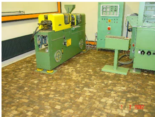
PCP-haltiger Hirnholzboden mit PAK-haltigem Kleber
