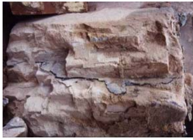
Mauerwerk mit schwarzer Sperrbahn gegen aufsteigende Feuchtigkeit
