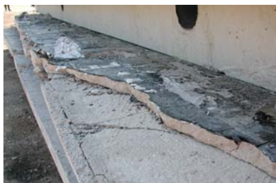
Schwarzanstrich und verklebte Sperrbahn (alukaschiert)
