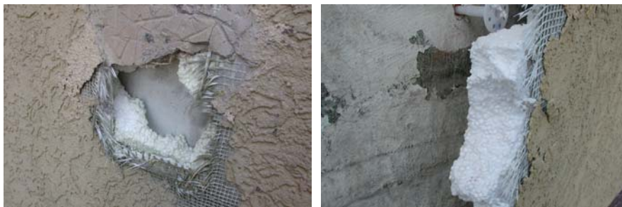
Vollwärmeschutz einer Hausfassade
