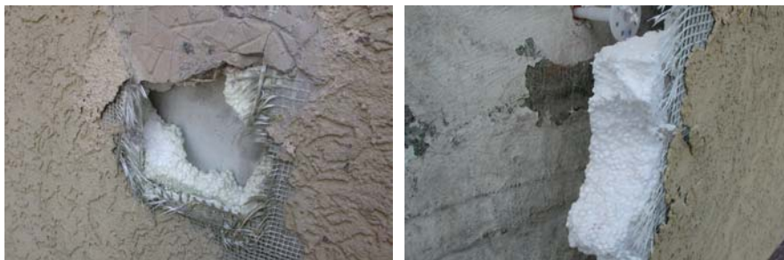
Vollwärmeschutz einer Hausfassade
