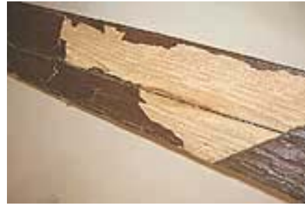
Detailaufnahme lackierte Dachbalken
