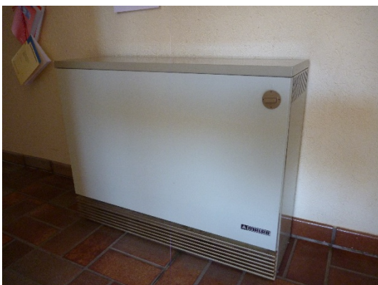
Abb. 1: Elektro-Nachtspeicherheizgeräte
