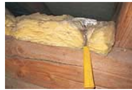
Dachisolierung aus KMF
