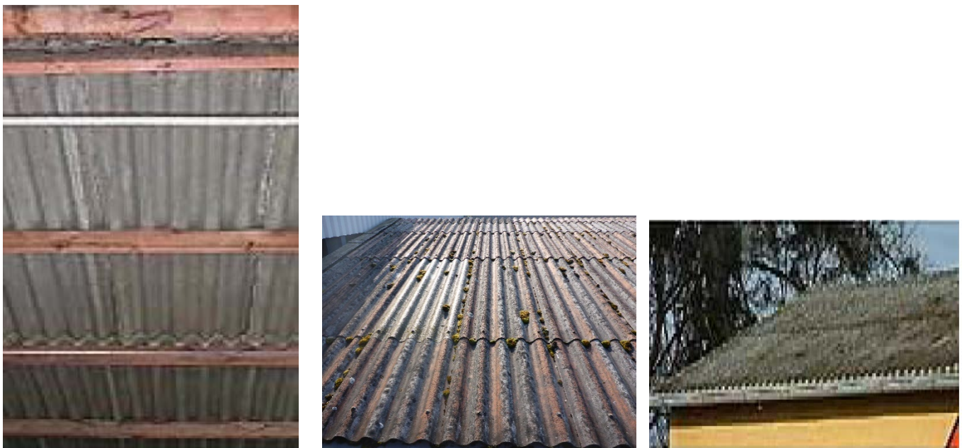
Abb. 1: Asbestzement-Wellplatten („Eternit“)
