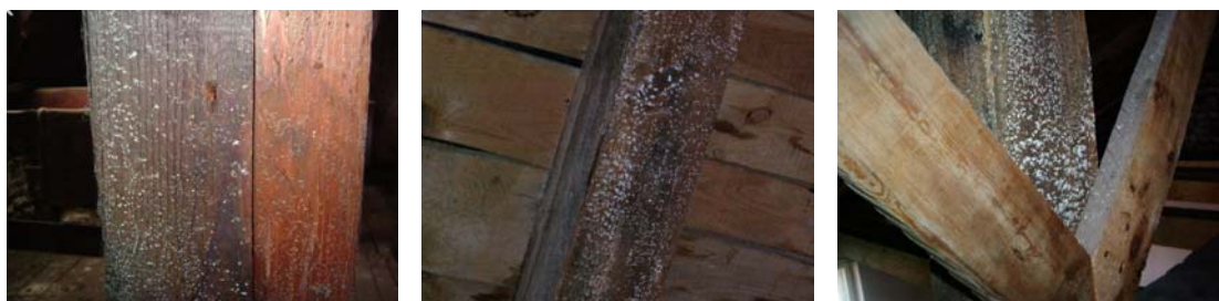
DDT-Kristalle auf Dachstuhlholz
