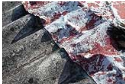
Anschlussblech aus Blei auf einem Dach aus Asbestzement
