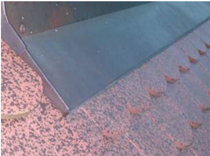
Abb. 1: Kupfer-Einblechung an einem Dachfenster
