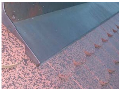
Einblechung an einem Dachfenster
