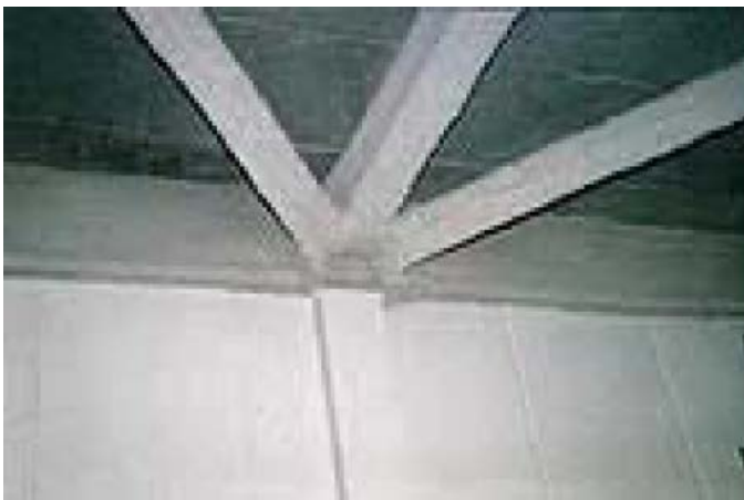
Abb. 1: Spritzummantelung von Strahlträgern (hier asbestfrei)
