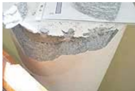
Asbestummantelung einer Betonsäule
