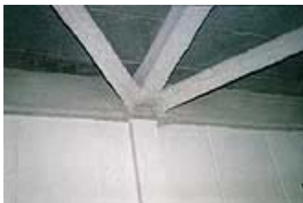
Spritzummantelung von Stahlträgern (asbestfrei)
