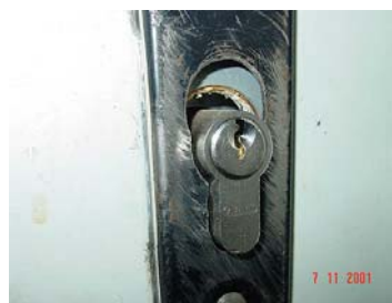
Brandschutztür mit Asbestplatte im Schlosskastenbereich
