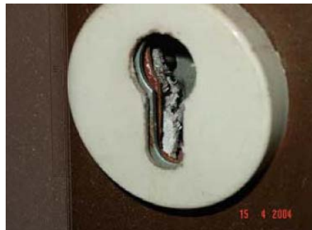
Abb. 2 . 3: Brandschutztür mit Asbestplatte im Schlosskastenbereich
