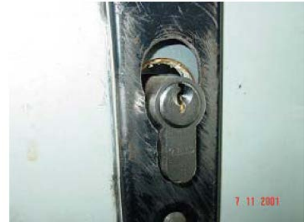
Abb. 2 . 3: Brandschutztür mit Asbestplatte im Schlosskastenbereich
