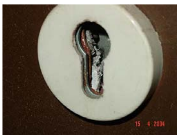
Brandschutztür mit Asbestplatte im Schlosskastenbereich
