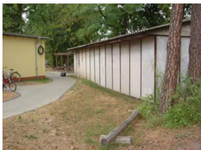
Asbestzementplatten (Wände) und Wellplatten (Wand)
