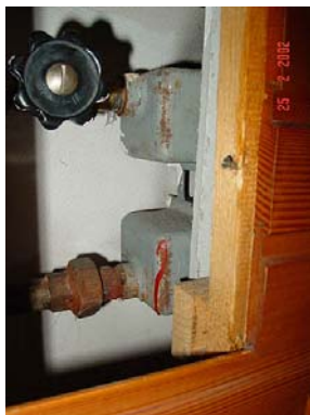
Heizkörperverkleidung mit Promabestplatten
