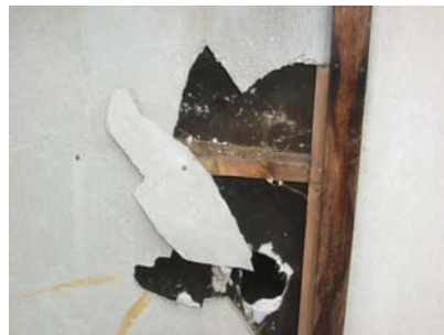
Asbestzementplatte auf Holzschalung
