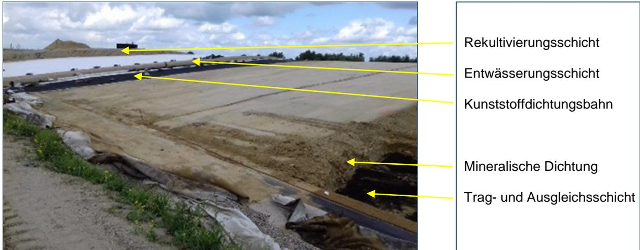
Abb. 1: Errichtung Oberflächenabdichtung
