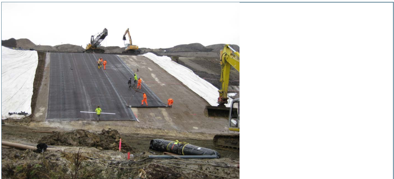
Abb. 5: Deponiebaumaßnahme mit Auflager, Drainage- und Bentonitmatten
