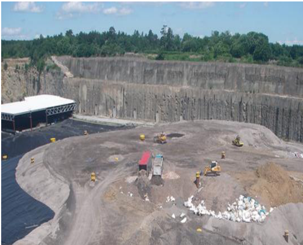
Abb. 1: Abfalleinbau auf einer Deponie
