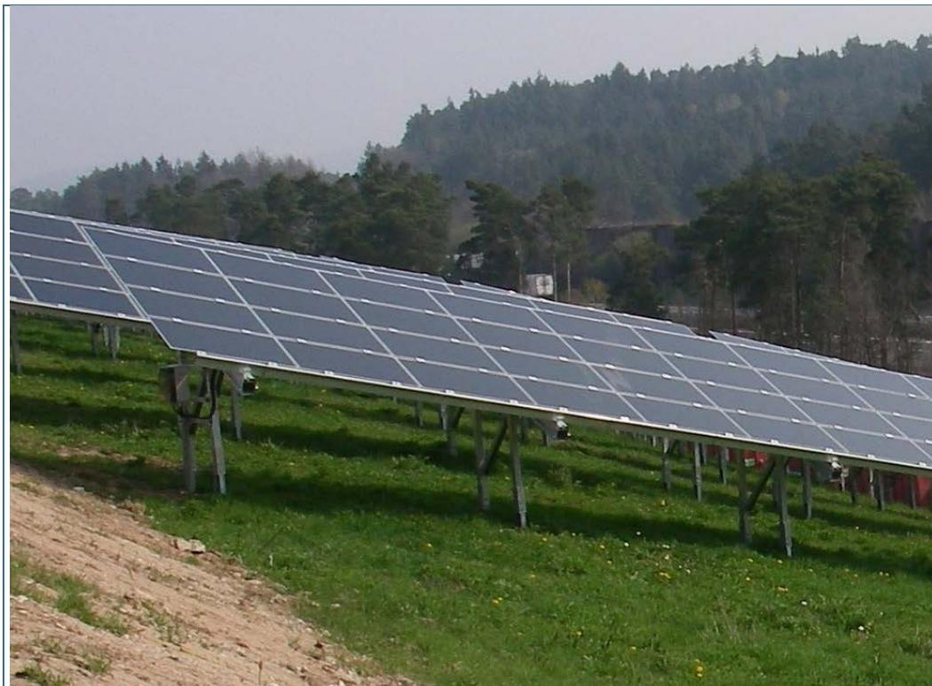
Abb. 1: PV-Module auf einer Deponie
